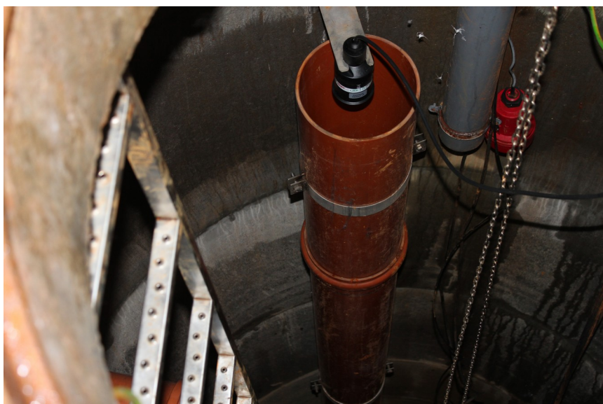
Fot.1 Rura separująca z zawiesiem dla ultradźwiękowego przetwornika poziomu
