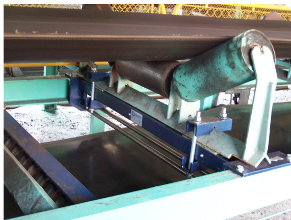
Pomost wagowy ACM – PT zainstalowany na obiekcie
